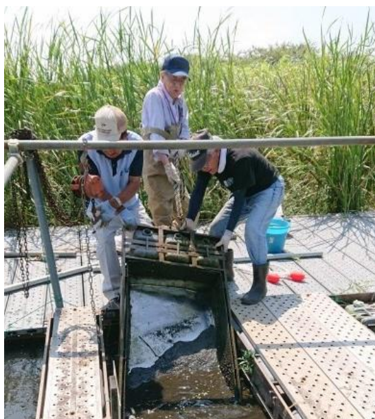
いかだ修理の為水槽引き上げ 2019. 7
