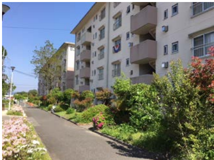
新たに設置される B38、39棟。2020年3月完成。
