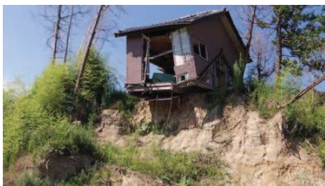
2階部分が津波で運ばれ崖の上に取り残された住宅＝南相馬市小高区
